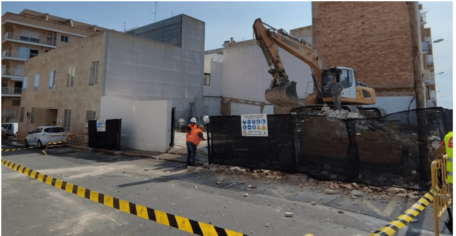
Obres d'ampliació del CAP de l'Ametlla de Mar.
